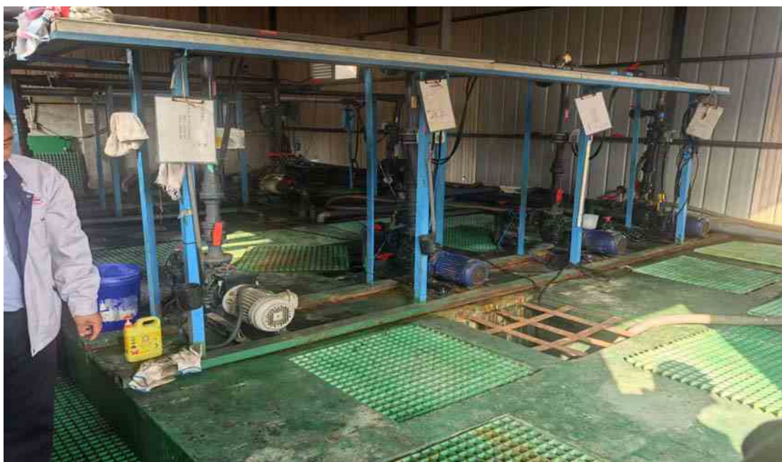
污水排口（泵打入污水管网）
